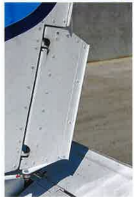
Aufgenietete Metallleisten an den Rudern sollen die Steuerung weniger schwammig wirken lassen.
